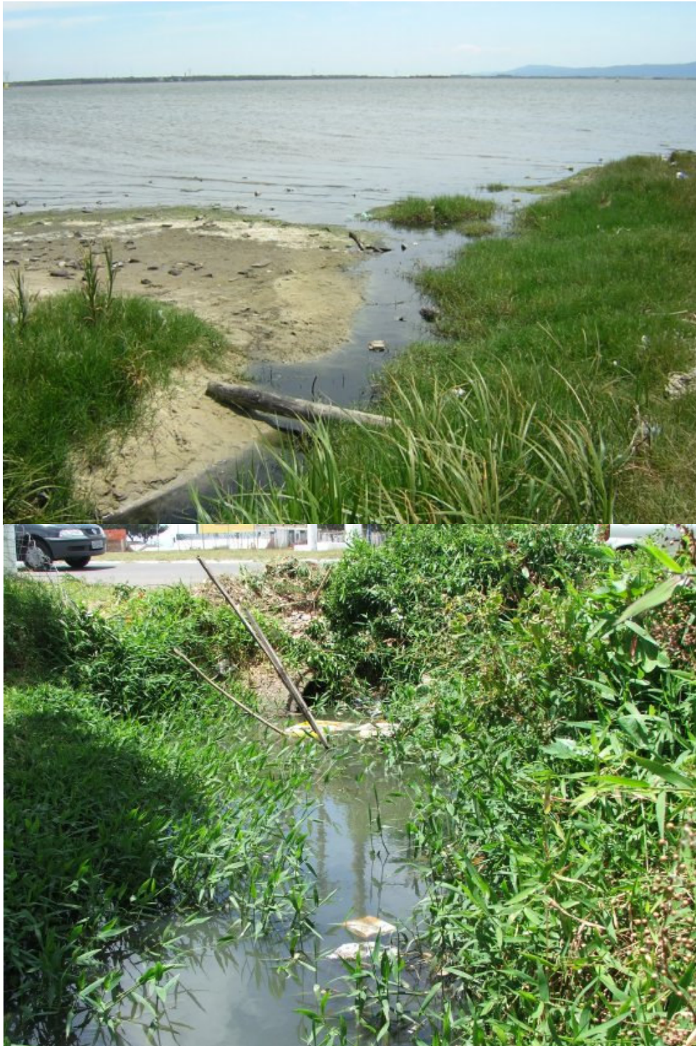
Figura 3.31: Foto superior: ponto #28. Canaleta a céu aberto situada no final da Rua João Pessoa, próximo à antiga estação rodoviária de Tramandaí. Foto inferior: ponto #29. Canaleta a céu aberto localizada na intersecção da Rua Ernesto Nunes Bandeira com a Avenida Rubem Berta, em Tramandaí. Ambos classificados como muito contaminados.
