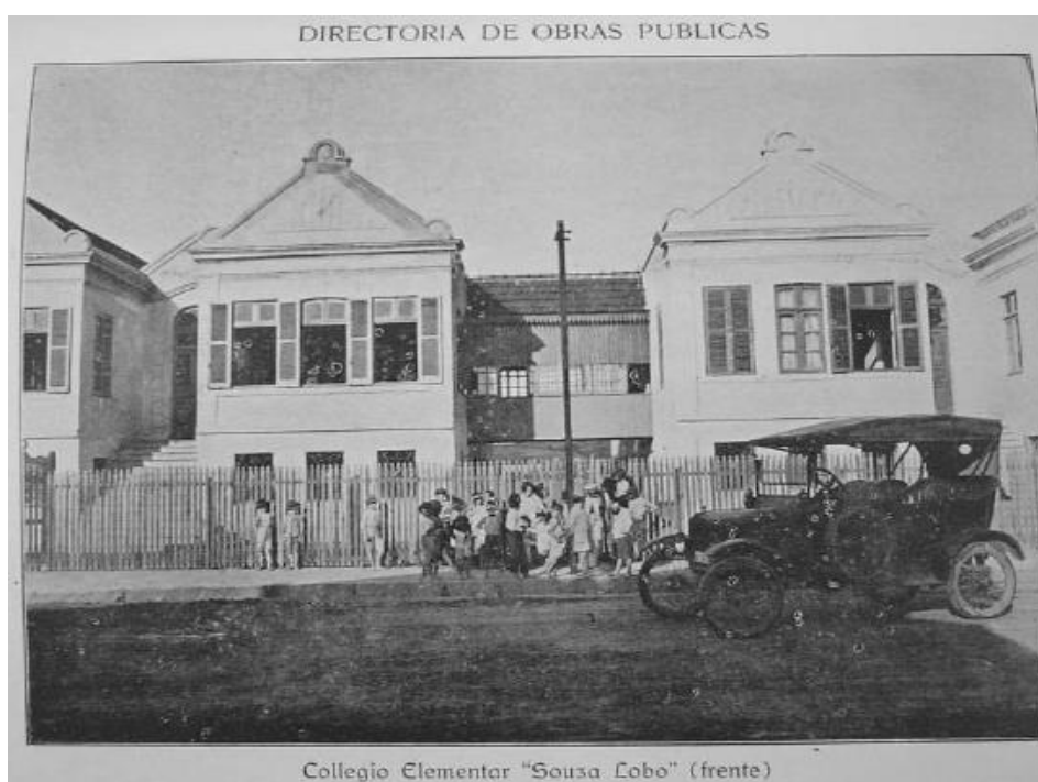
Figura 7 – Conjunto arquitetônico da primeira edificação da Escola Estadual de Ensino Fundamental Souza Lobo
