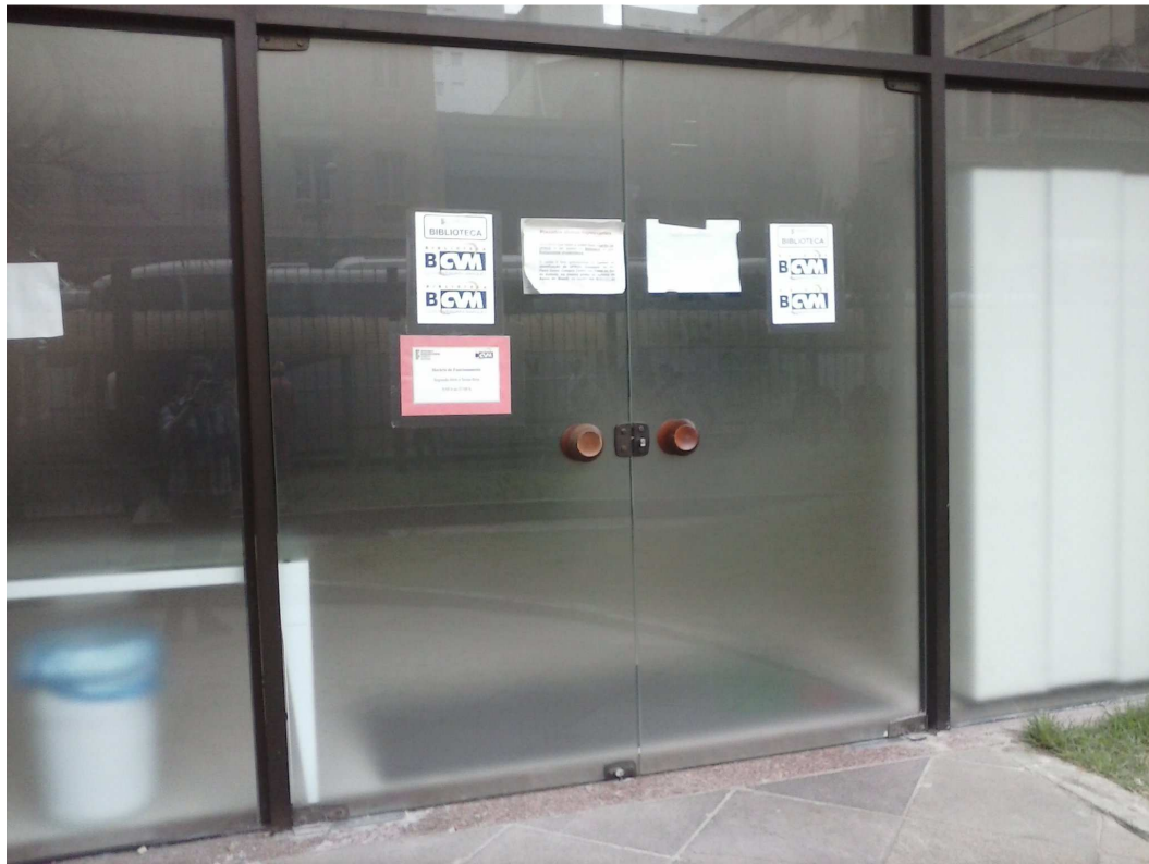
Figura 6 – Porta de Entrada da Biblioteca Clóvis Vergara Marques
