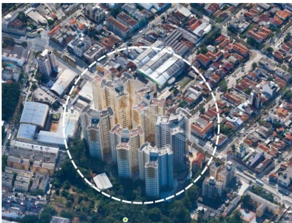
Figura 3.43: Edifício 3 Fonte: Google Maps, 2013
