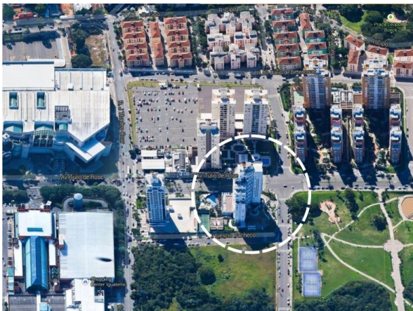
Figura 3.41: Edifício 1 Fonte: Google Maps, 2013
