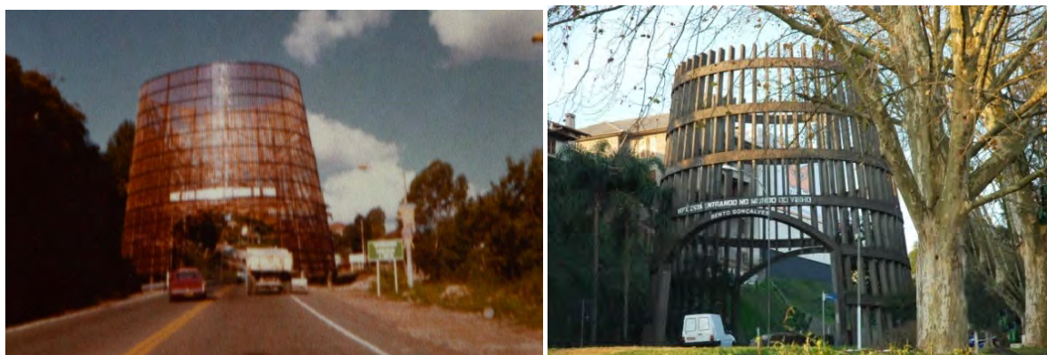
Figura 98 - Pipa - Pórtico de madeira na entrada da cidade de Bento Gonçalves (década de 1970) - Substituída em (1985) por concreto armado.
