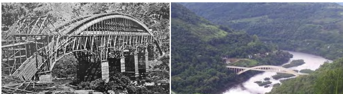
Figuras 91 e 92: Construção da ponte sobre o Rio das Antas (1944) e a ponte na atualidade, referenciada como cartão postal da região
