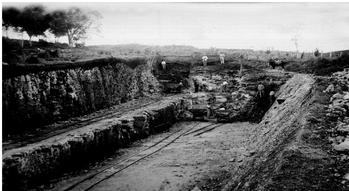
Figura 76 - Construção da estrada de ferro em Bento Gonçalves (1918)
