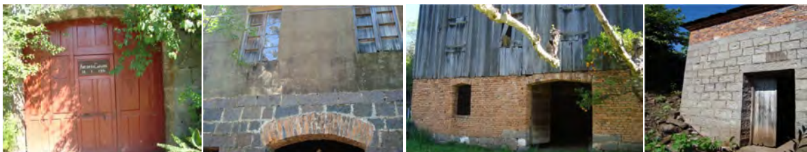
Figuras 52 a 55 - Arquitetura das cantinas no Vale dos Vinhedos
