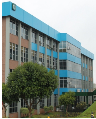
Foto 01: prédio Azul, localizado no Campus II da Universidade Feevale Fonte: AUTORA, 2013
