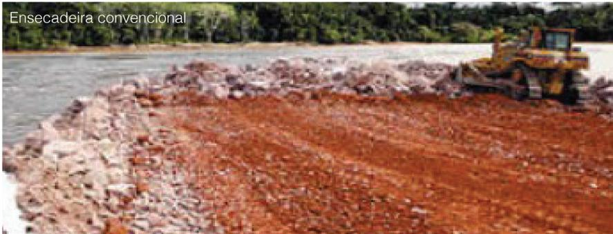
A escolha do tipo de ensecadeira e o seu dimensionamento dependem de diversos fatores, podendo citar: fatores topográficos, hidrológicos, hidráulicos, ambientais, das características da obra a ser executada (porte e tipo de barragem), cronograma da obra, riscos aceitáveis, entre outros. A análise desses fatores, muitas vezes, depende de estudos individualizados e específicos em modelos reduzidos.
