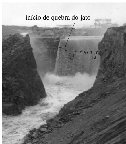
Figura 3.7 – início de quebra do jato – barragem de Ricobayo, Espanha (ANNANDALE, 2006, p. 374)
