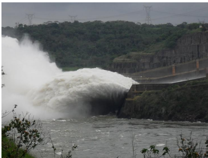
Figura 1.2– jato do vertedouro salto esqui da usina hidrelétrica Itaipu Binacional Fonte: Lucélia Ignácio 2
