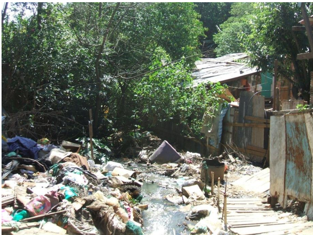
Figura 45: Lixo e entulho depositado na calha do arroio Vila Pinto. À direita, moradias em risco de inundação.
