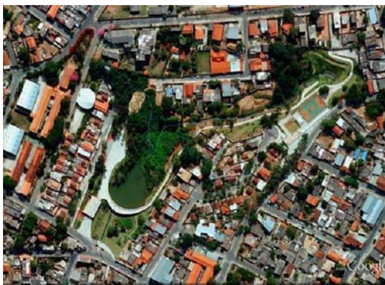
Figura 28: Imagem de satélite da Bacia do Córrego Primeiro de Maio, após execução do projeto de revitalização do DRENURBS, em 2010.
