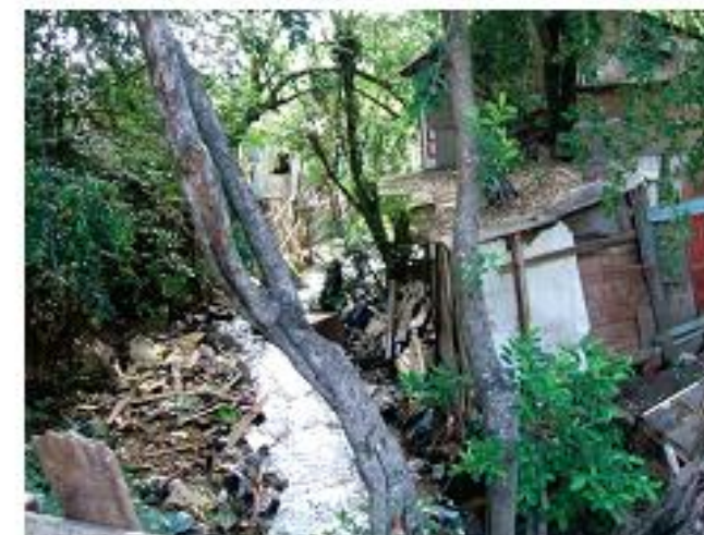
Planície de inundação do arroio da vila pinto, nas proximidades da rua "P", ocupada por moradias com alto risco de inundação. Extraído de PMPA (2011a).
