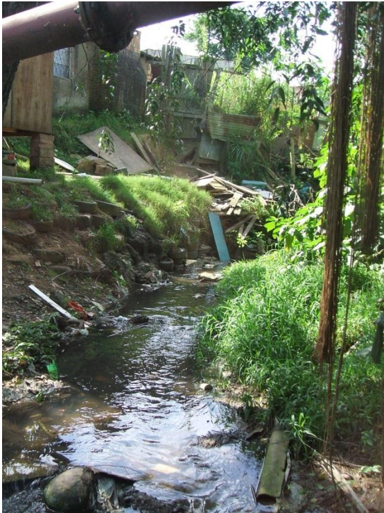
Figura 43: Situação de moradia situada dentro da calha do Arroio Riacho Doce.
