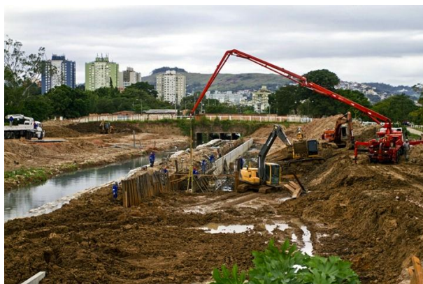
Figura 03: Canalização do Arroio Cavalhada em 2013. Autora Paula Fiori. Fonte: PMPA, 2013.
