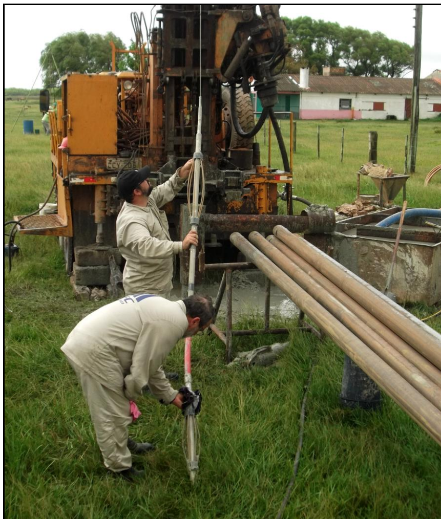
Figura 7 - Perfilagem geofísica realizada nos poços de monitoramento.
