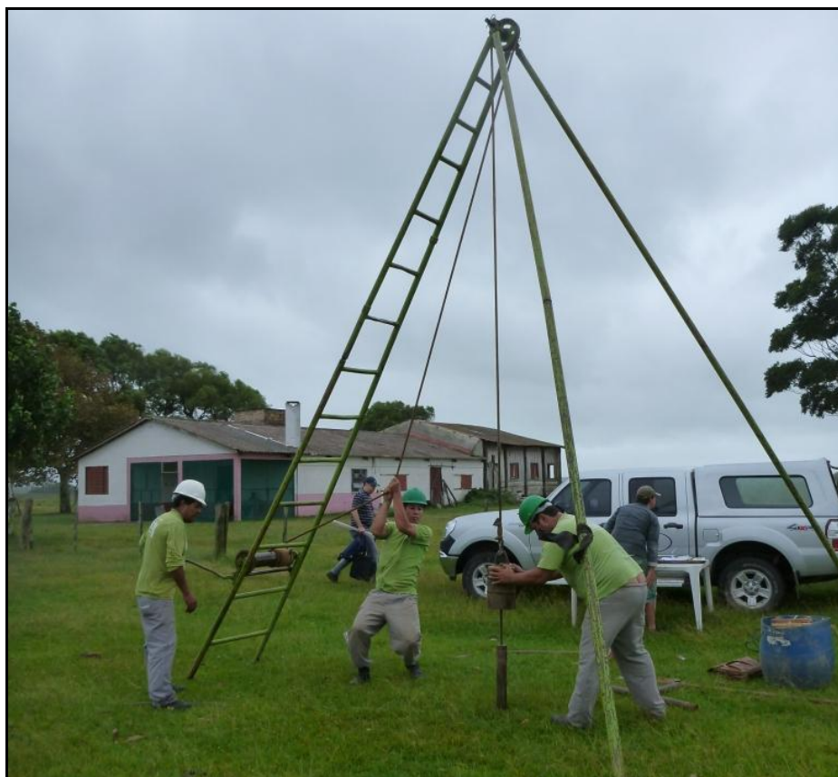
Figura 8 - Sondagem executada através do método de percussão simples.
