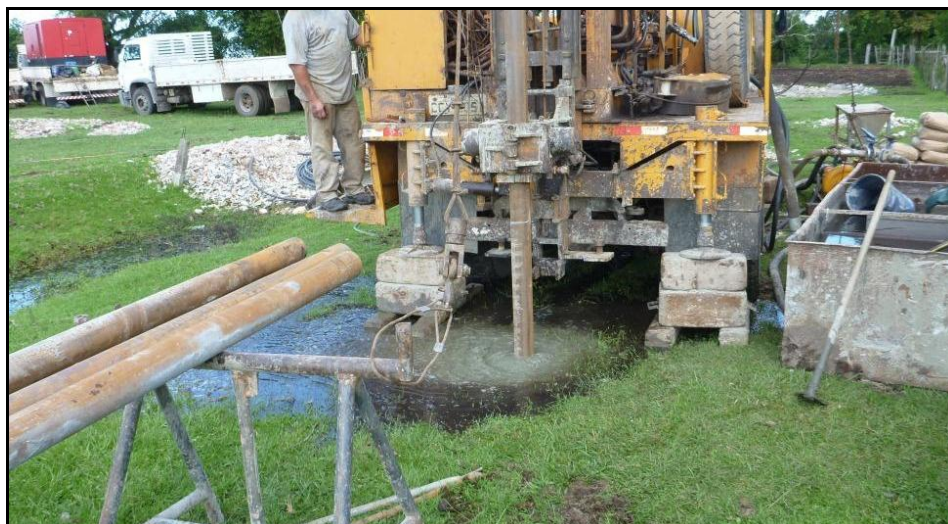
Figura 6 - Perfuração de poços de monitoramento através do método rotativo.
