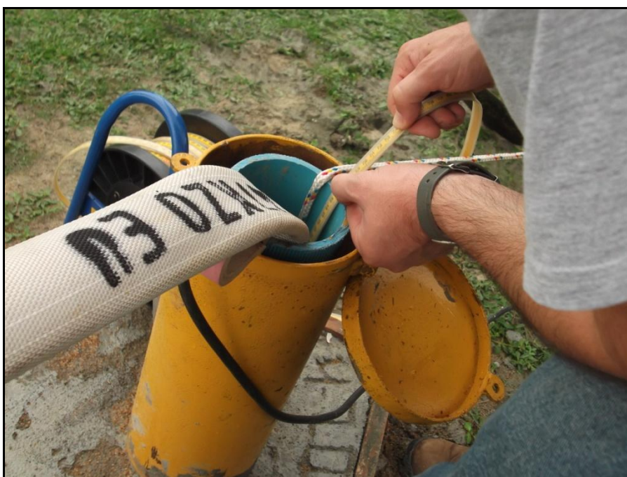
Figura 11 - Observação do nível da água durante o ensaio de bombeamento.
