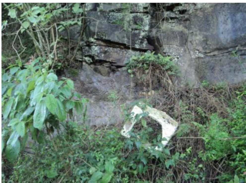
Figura 33 – Circulação de água entre fraturas
