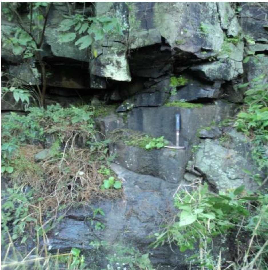
Figura 34 – Circulação de água entre fraturas
