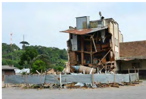
Moinho após a demolição.
