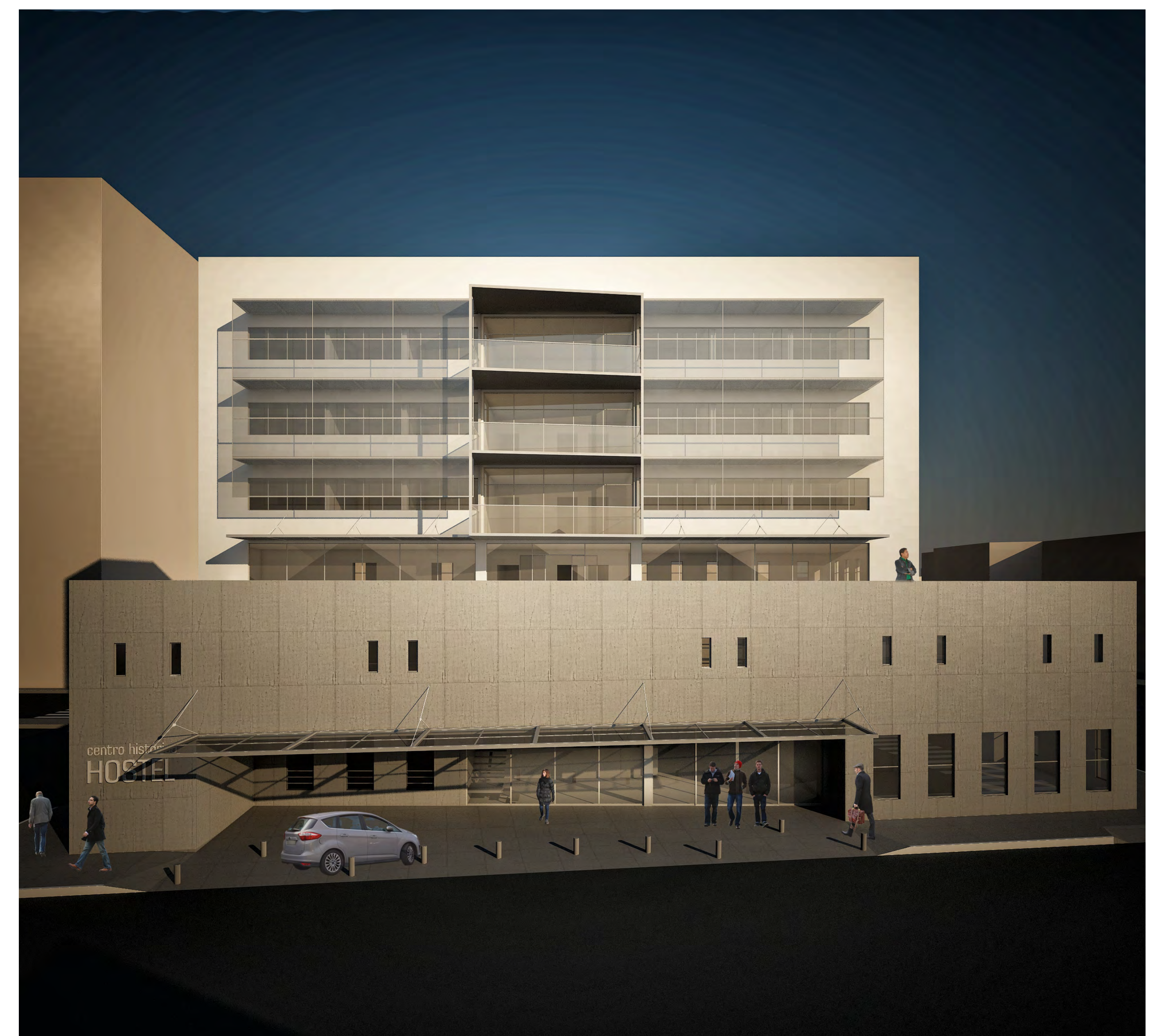
vista fachada norte
