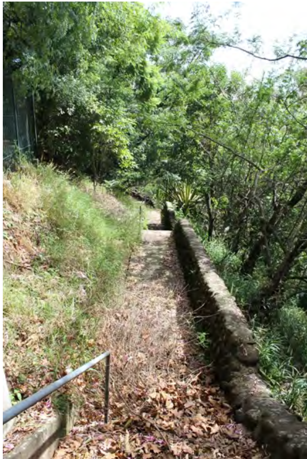
vista 11 - a escadaria da encosta vista de cima, abandonada
