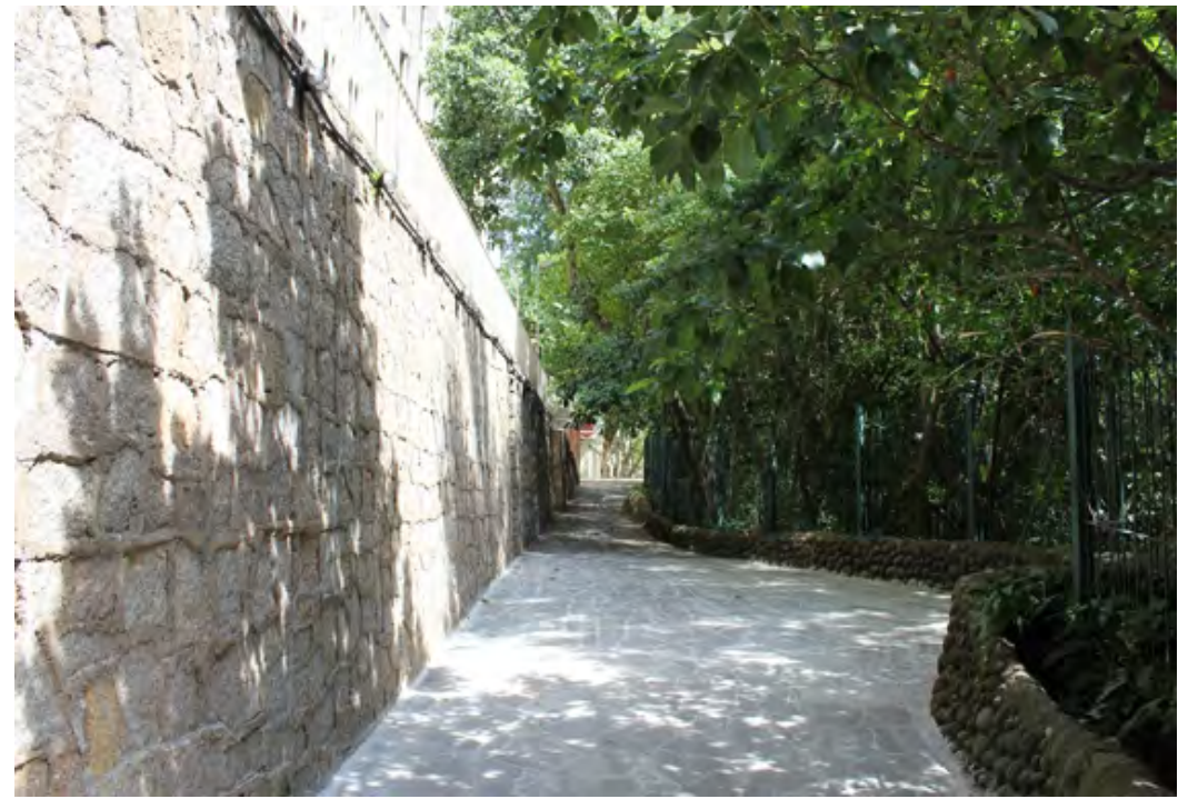
vista 13 - a mesma passagem vista no outro sentido, com um alargamento junto à encosta do morro Ricaldone
