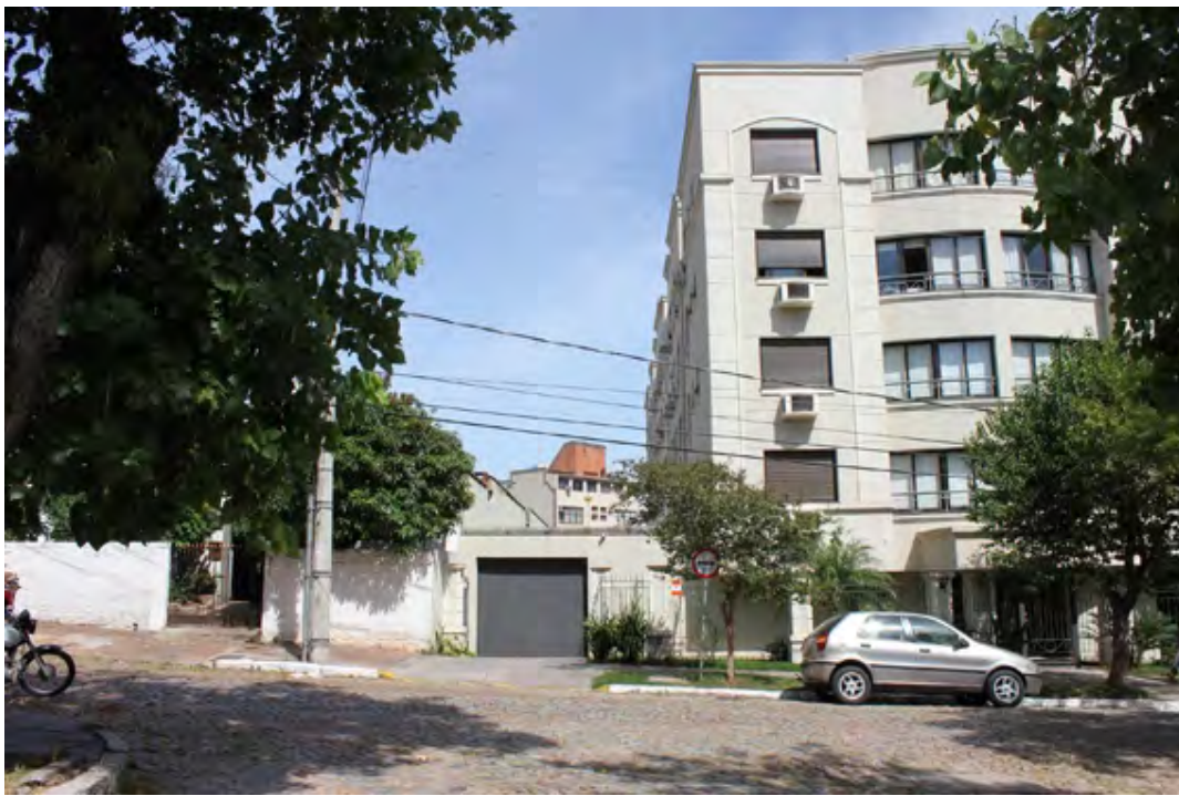
vista 01 - a edificação vizinha
