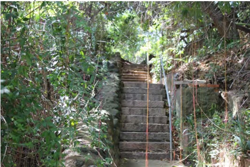
vista 10 - a escadaria da encosta encerrada pelas grades
