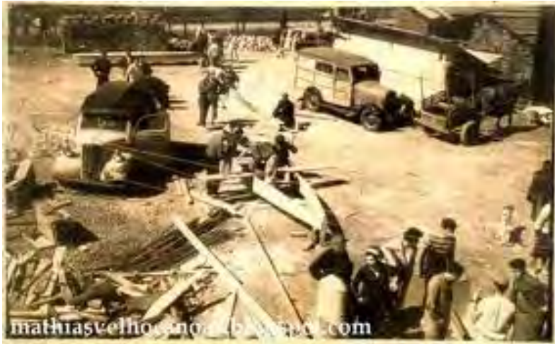
Comunidade construindo Canoas para fugir da cheia
