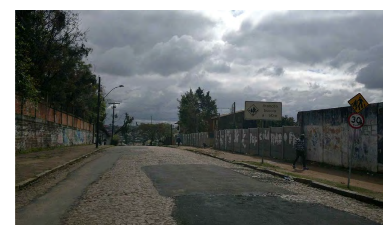
Vista do terreno | R. São Miguel
