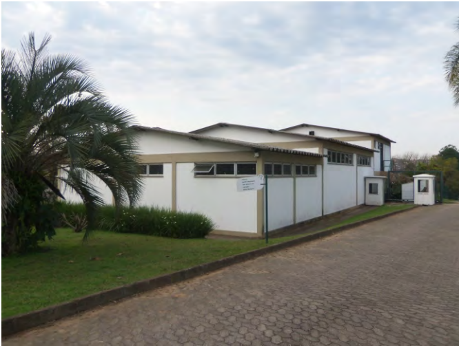
Edificação para depósito e maquinários
