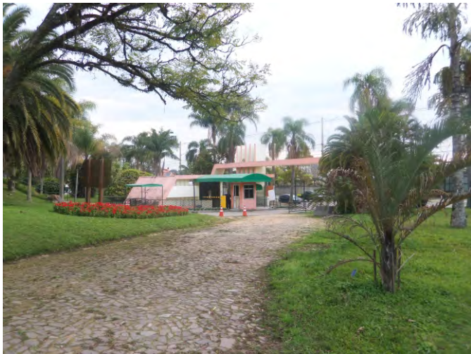
Vista interna entrada principal
