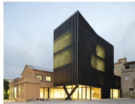
Centro Cívico de Ferreries, Espanha. Arquitetos Olga Felip e Josep Camps
