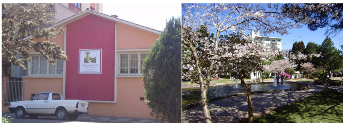
Figura 5: Fachada principal da sede do Serra Catarinense Convention & Visitors Bureau e praça defronte. Fonte: foto do autor.
