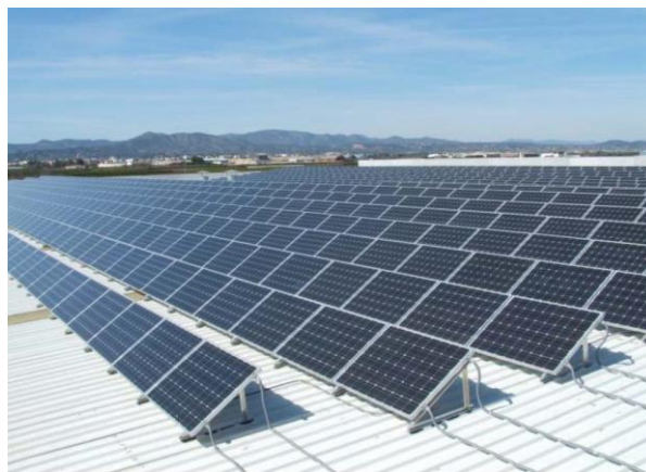
Figura 7 – Exemplo de aplicação onde o painel é ajustado para ter melhor desempenho e é mostrada a zona de sombra.
