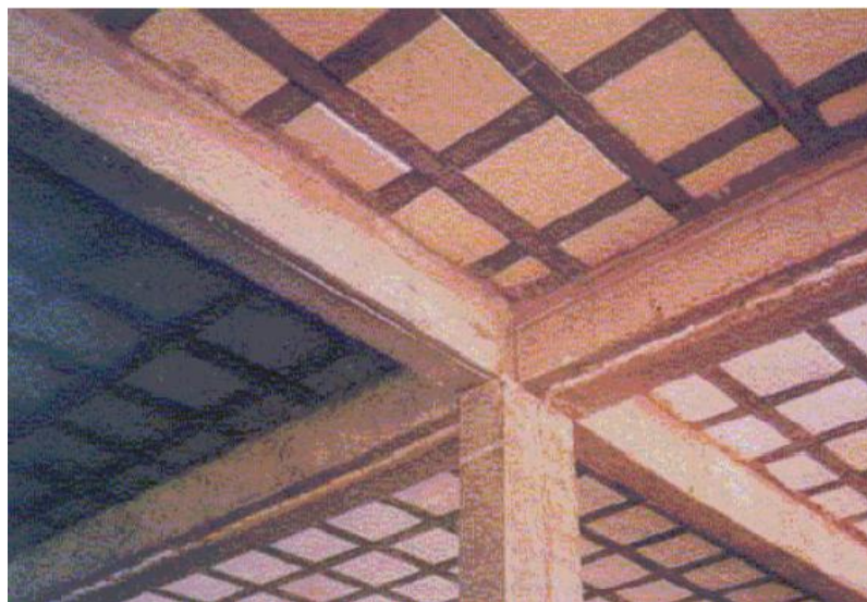
Figura 2 – Laje nervurada bidirecional com nervuras paralelas equidistantes em cada uma das direções
