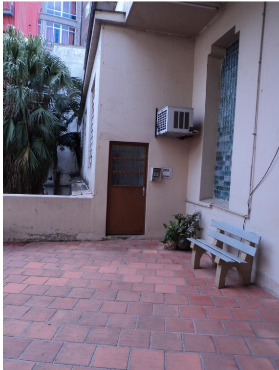
Figura 30 – Porta de acesso a áreas de uso restrito
