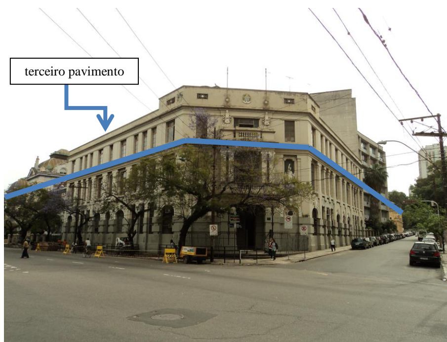
Figura 5 – terceiro andar do Instituto Eletrotécnico
