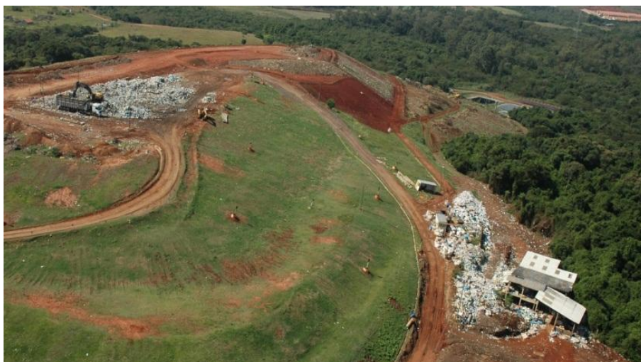
Figura 3.3 – Aterro de Guajuviras em fase de encerramento, operando como estação de transbordo
