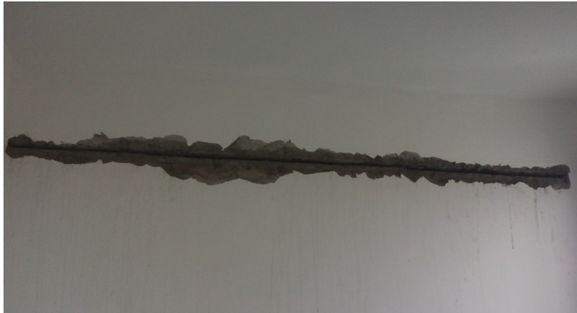
Figura 36 – Execução de reparo em fissura de encunhamento
