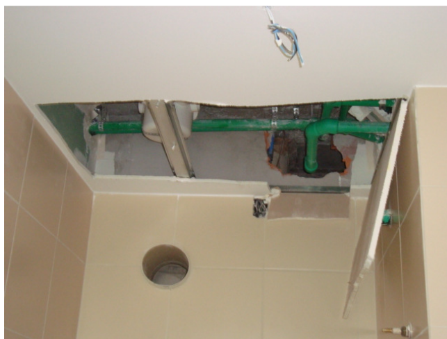
Figura 90 – Forro de banheiro aberto para conserto da rede hidráulica
