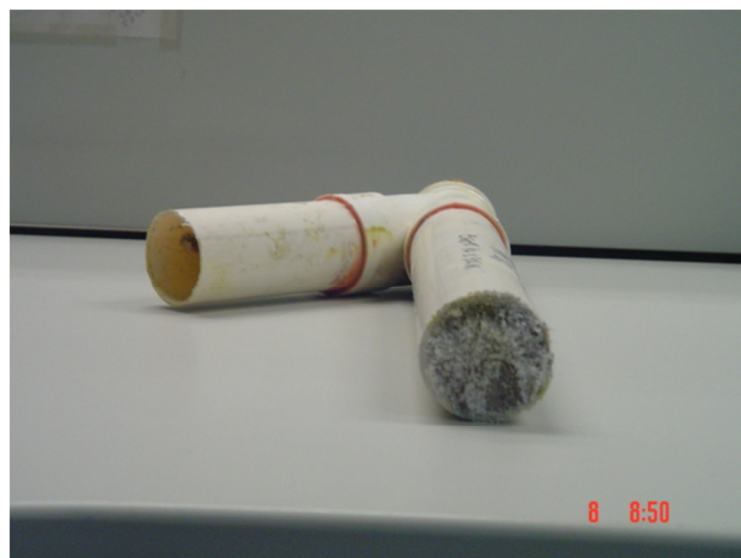
Figura 77 – Entupimento de tubulação
