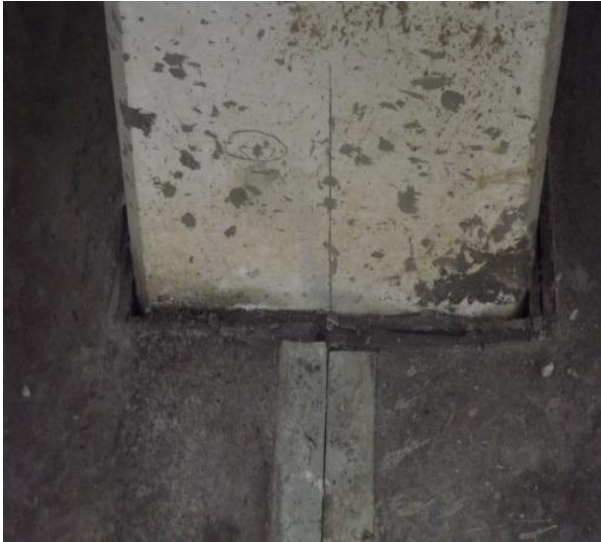
Figura 17 – Junta de encontro com borracha de poliuretano
