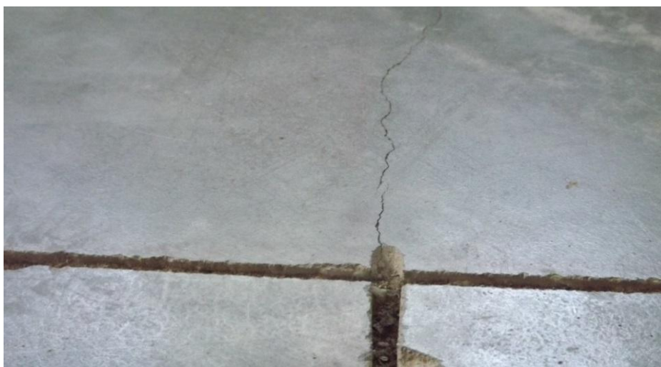
Figura 16 – Junta serrada terminada em junta de construção
