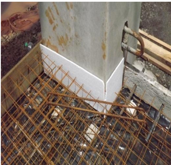
Figura 19 – Junta de encontro preenchida com Isopor
