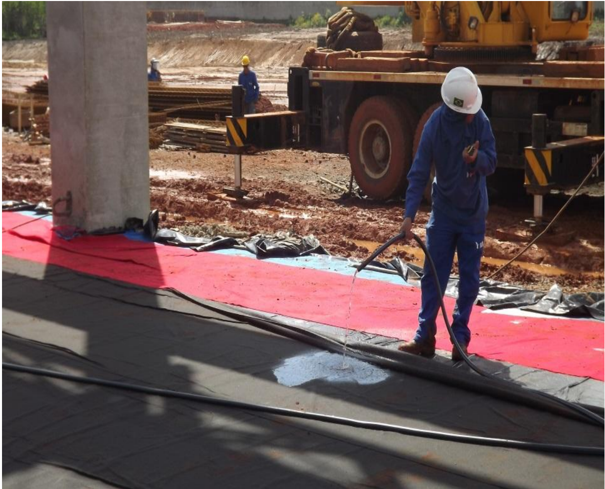
Figura 13 – Cura úmida realizada na Obra E
