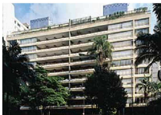
Figura 7 – Edifício Prudência: primeiro edifício com espaços flexíveis
