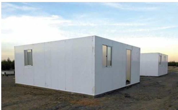
Figura 24 – Painel metálico tipo sanduíche (aço galvalume + poliuretano + aço galvalume)
