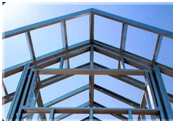
Figura 27 – Steel frame : perfis de aço
