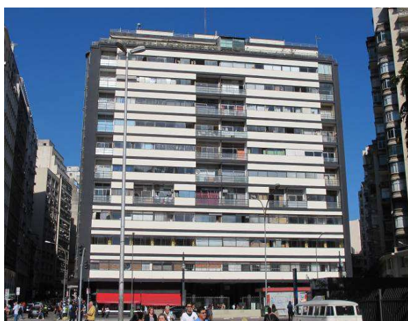
Figura 6 – Edifício Esther: primeiro grande edifício com estrutura independente de concreto (foto de julho de 2012)
