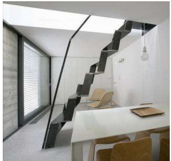
Figura 37 – Escada compacta (degrau diferencial: 2 com espaço de 1)
