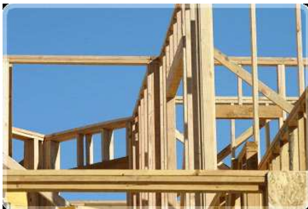
Figura 26 – Wood frame : perfis de madeira
