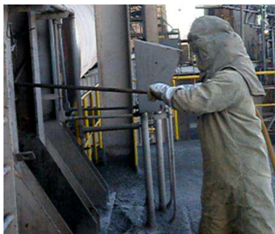
Figura 11: Limpeza de maçarico
