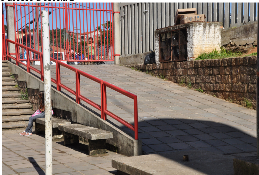
Figura 18. Rampa de acesso à escola 2
