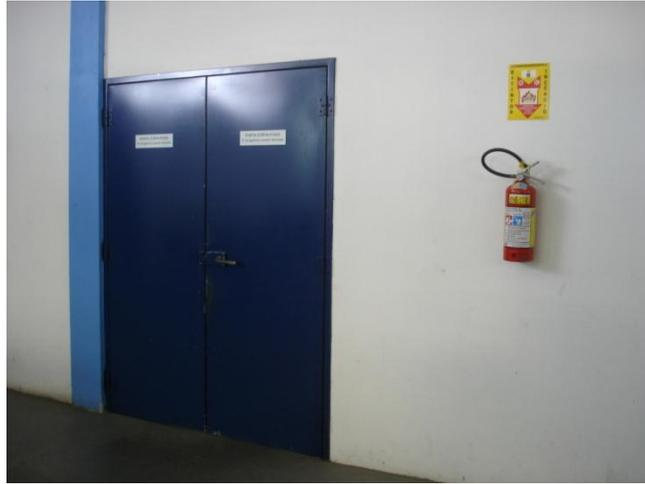
Figura 3.6 – Porta Corta-Fogo e Sinalização de Saída de Emergência
