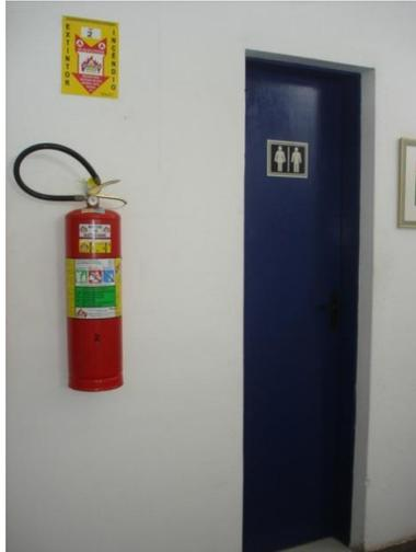
Figura 1.7 – Extintor de Água Pressurizada
