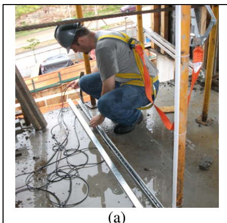
Figura 126: foto ilustrativa da passagem dos cabos pela canaleta metálica
