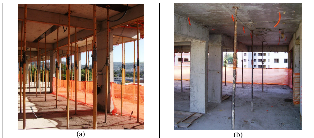
Figura 24: modelos de pontaletes utilizados nos ensaios de campo
