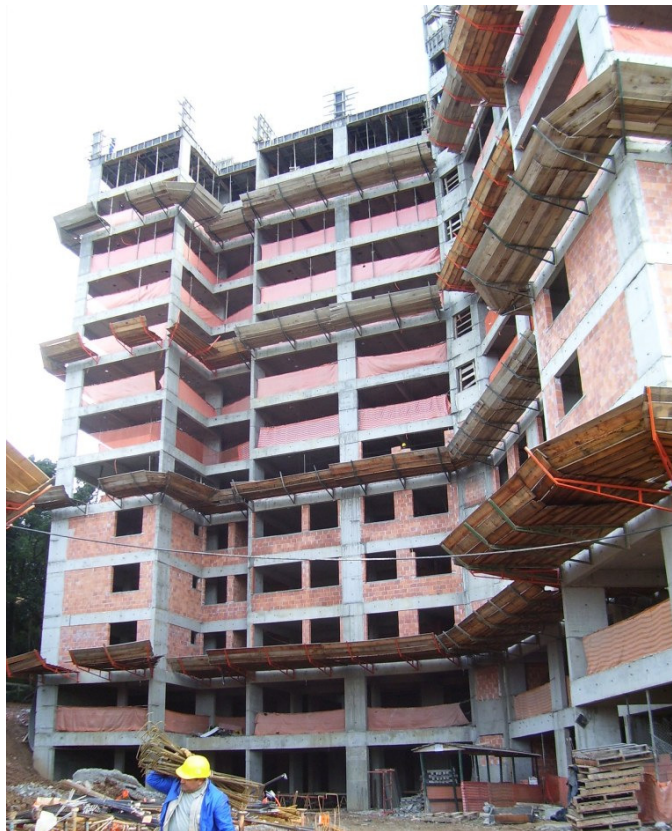
Figura 155: foto do empreendimento em construção
