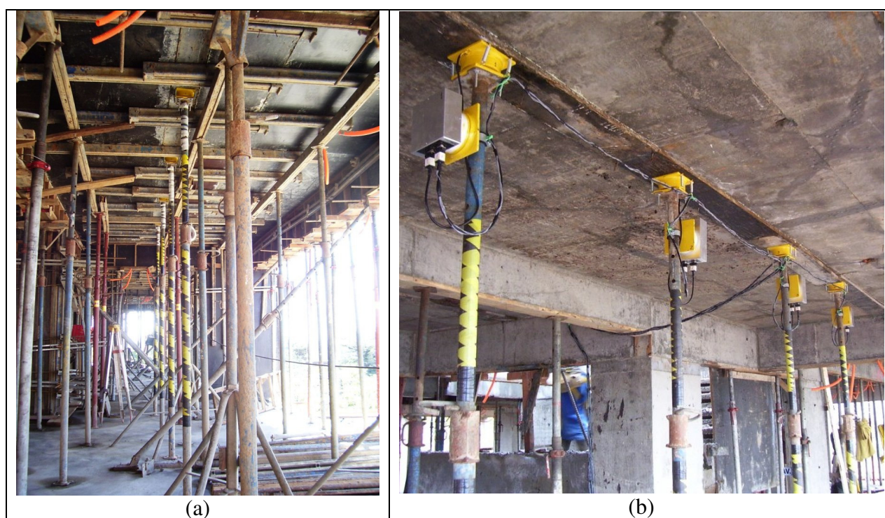
Figura 59: montagem do segundo ensaio teste. (a) reescoramento instrumentado juntamente com o escoramento, (b) somente os pontaletes instrumentados sob a faixa de reescoramento
