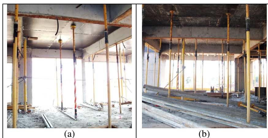
Figura 107: fotos ilustrativas do reescoramento e vigamento dos painéis das lajes
