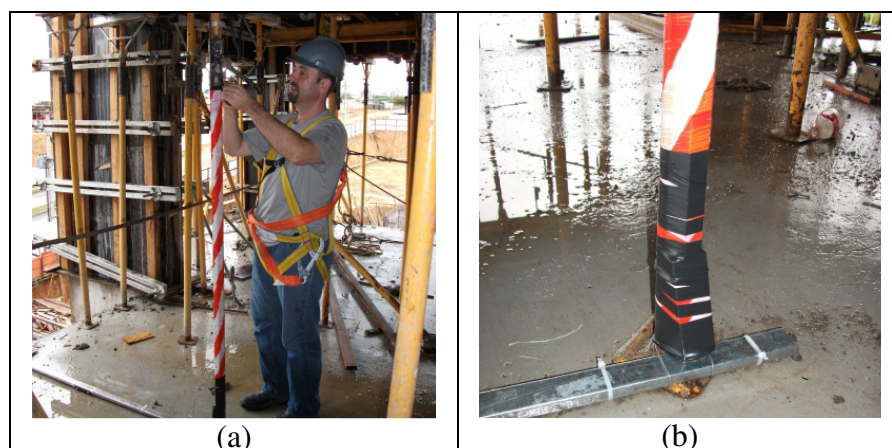
Figura 130: fotos ilustrativas da fita zebra no pontalete
