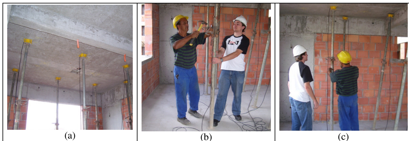
Figura 156: teste de aperto dos pontaletes
