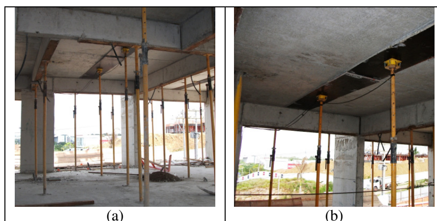
Figura 133: fotos ilustrativas da retirada da proteção dos cabos e passagem pelo teto
