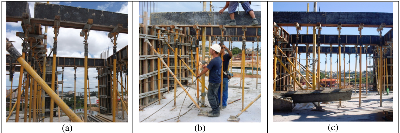
Figura 73: fotos ilustrativas dos painéis laterais das vigas
