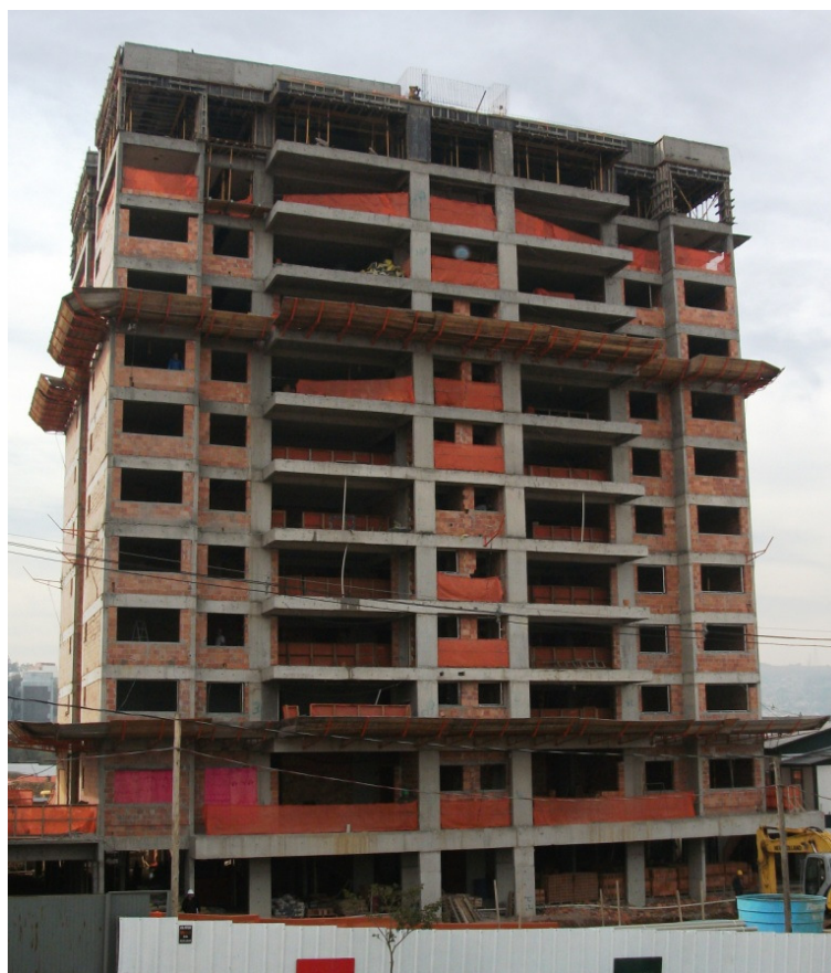
Figura 63: foto do empreendimento em construção
