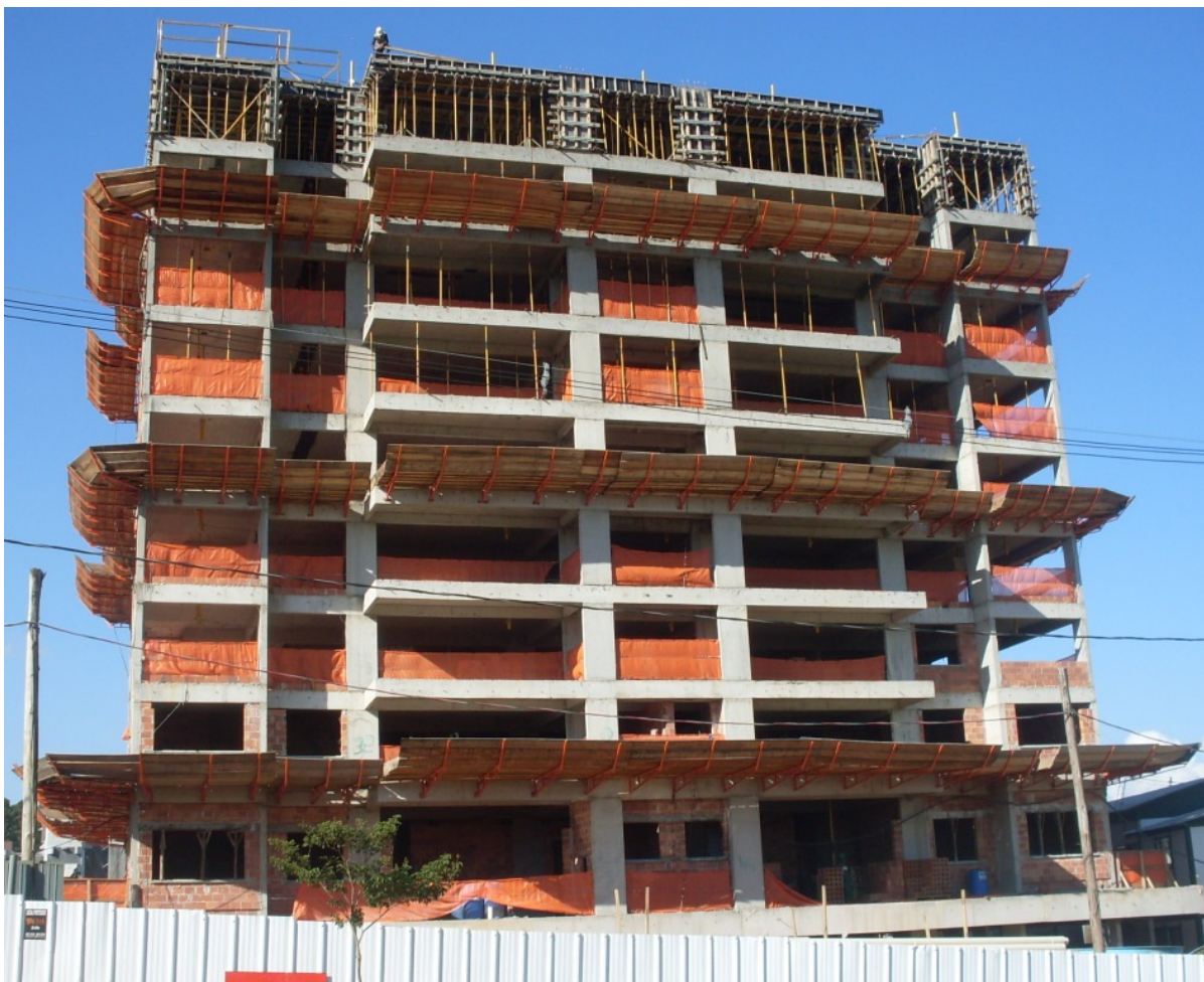
Figura 01: exemplo de construção com cinco pavimentos ligados por meio de pontaletes
