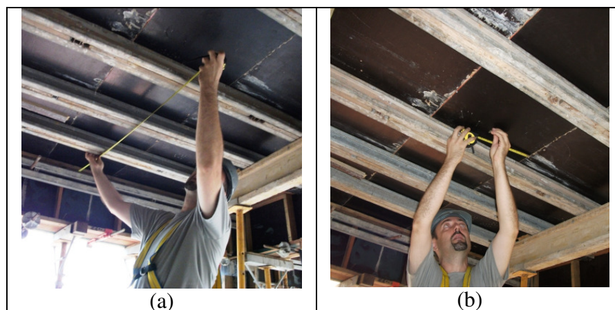
Figura 119: fotos ilustrativas da marcação dos pontaletes
