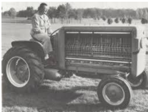
Figura 2. Trator de célula a combustível Allis Chalmers, 1959 (retirado de [26]).
