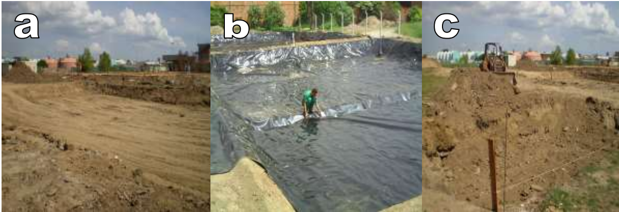
Figura 4. a: retirada de material para colocação da lona; b: colocação da lona de revestimento; e c) recolocação do solo retirado.
