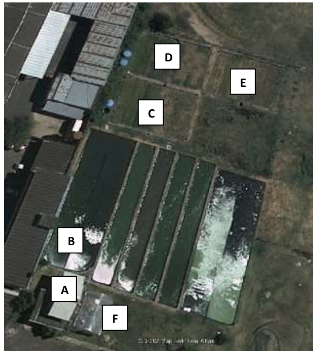
Figura 1. Vista da área do experimento. A: Reator Anaeróbio – TDH-10; B: Lagoa de Polimento – TDH-30; C: Tratamento 1 (T1) ; D: Tratamento 2 (T2); E: Tratamento 3 (T3); F: Casa de Vegetação. Porto Alegre-RS (01/06/2009). Fonte: GOOGLE EARTH – MAPAS (2012).
