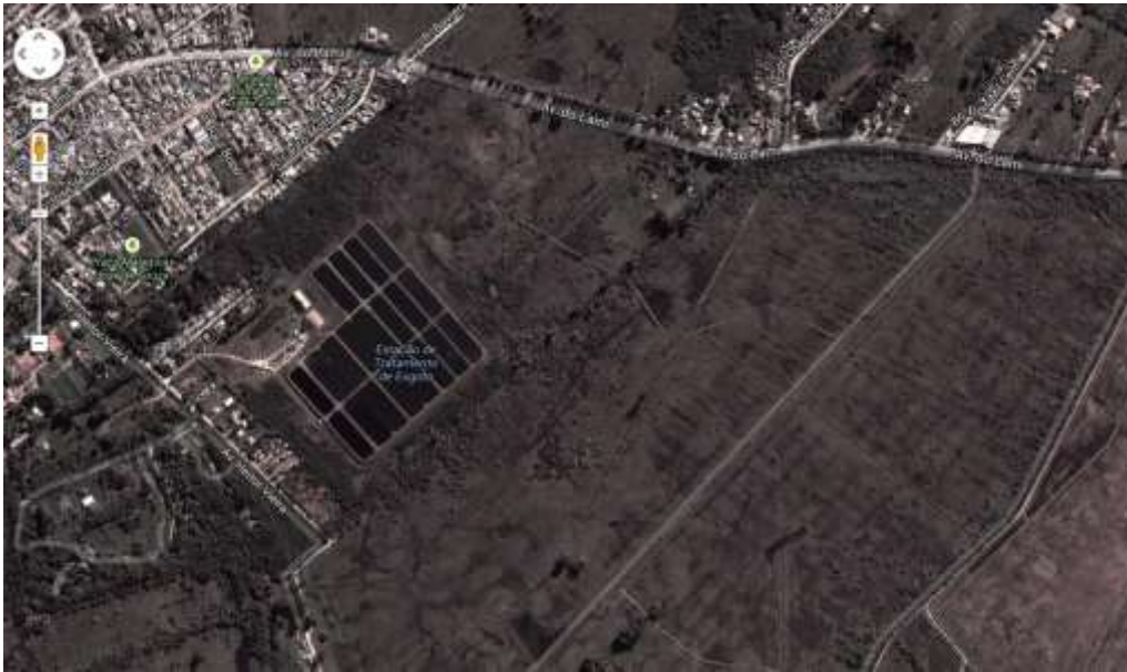
Figura 8. Estação de Tratamento de Esgoto Belém Novo. (Porto Alegre-RS) Fonte: Google Earth (2013).
