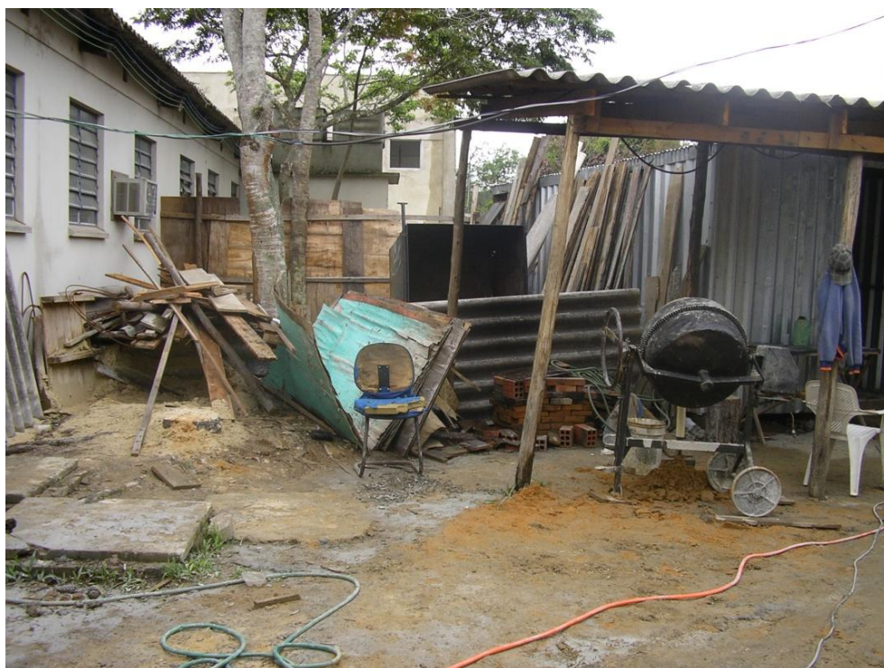
Figura 24– Ordem e limpeza obra 2
