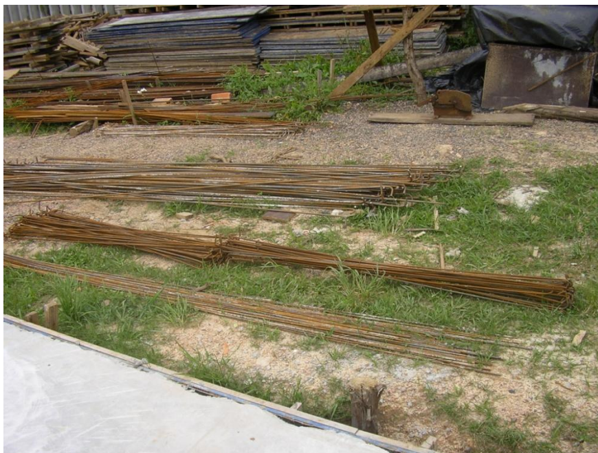
Figura 36– Vista armazenagem de aço
