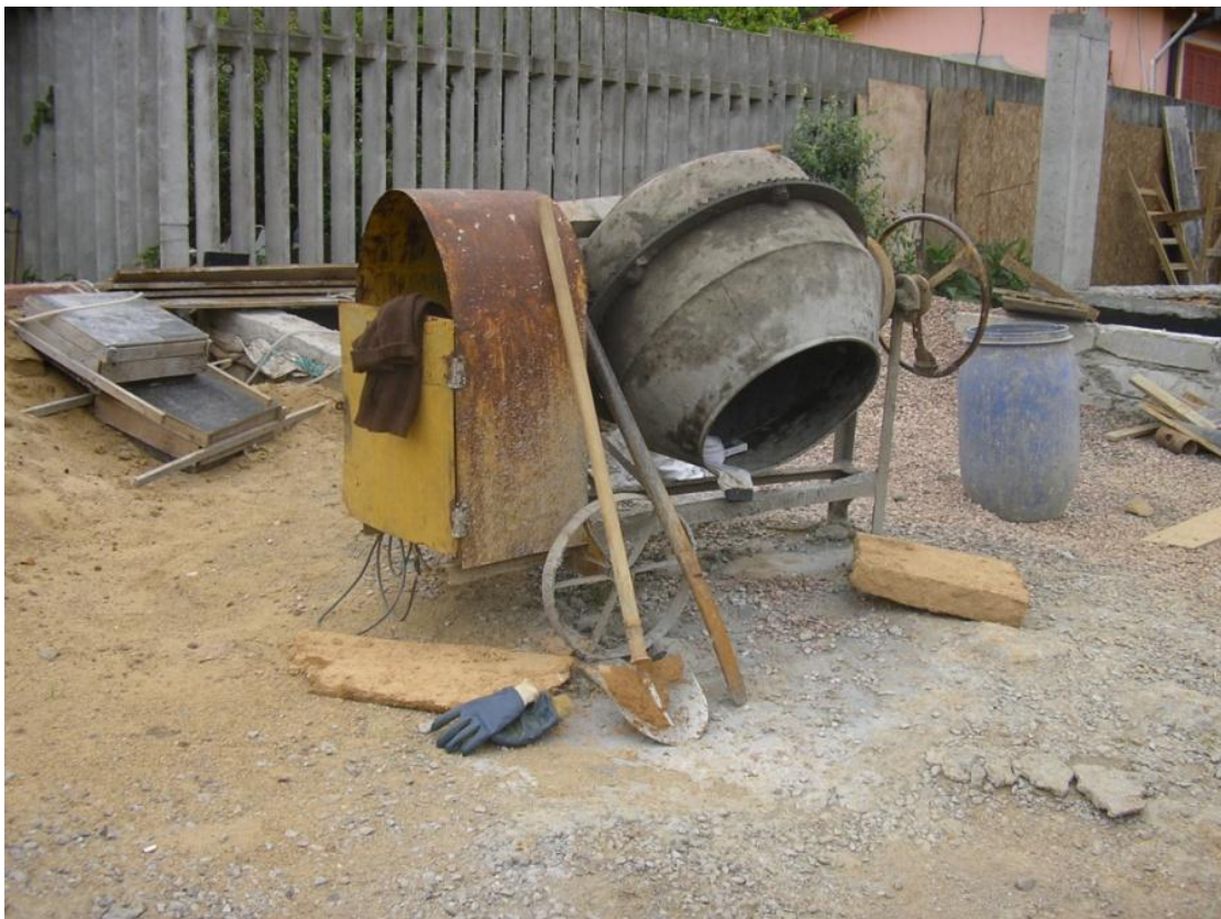
Figura 37– Vista área de betoneira
