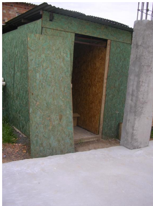
Figura 28– Vista escritório (b)
