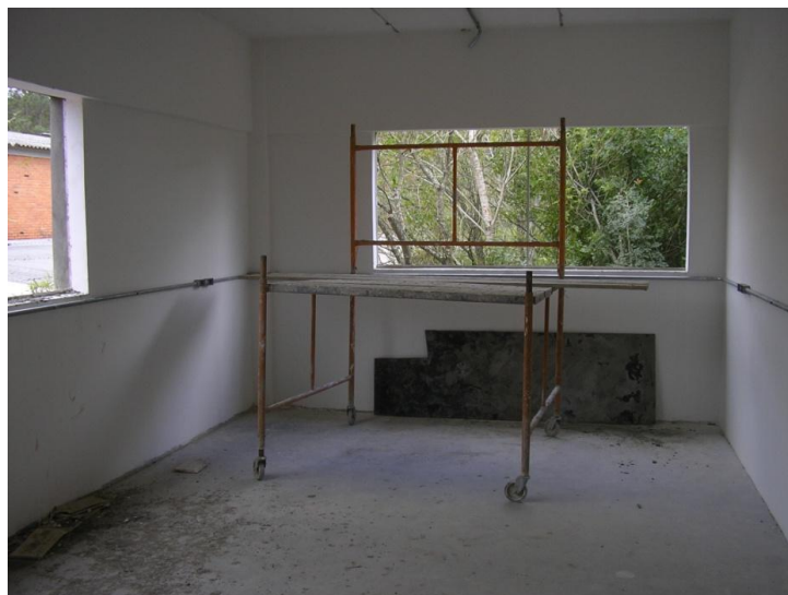
Figura 21– EPI obra 3 (b)
