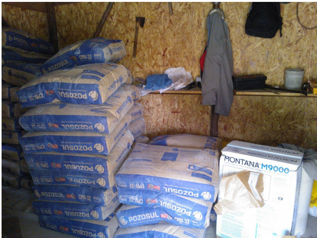
Figura 10– Vestiário obra 4 (b)
