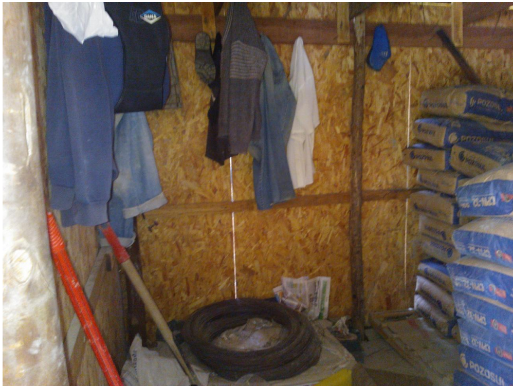
Figura 9– Vestiário obra 4 (a)
