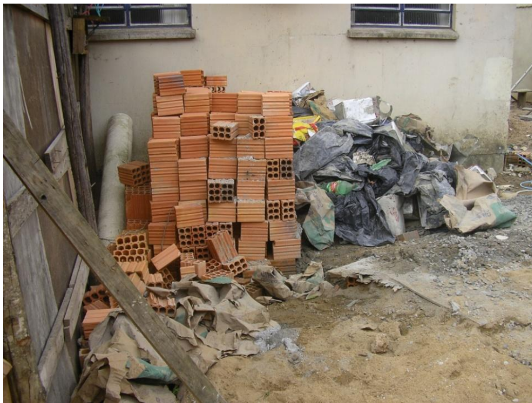
Figura 25– Ordem e limpeza obra 3
