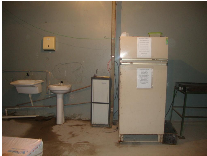
Figura 14– Refeitório obra 5 (c)
