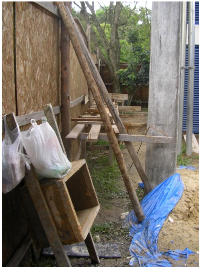
Figura 18– Bancada de armações de aço obra 2 (a)
