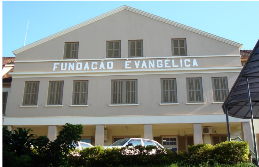
Figura 4.2: Fachada atual da Escola.
