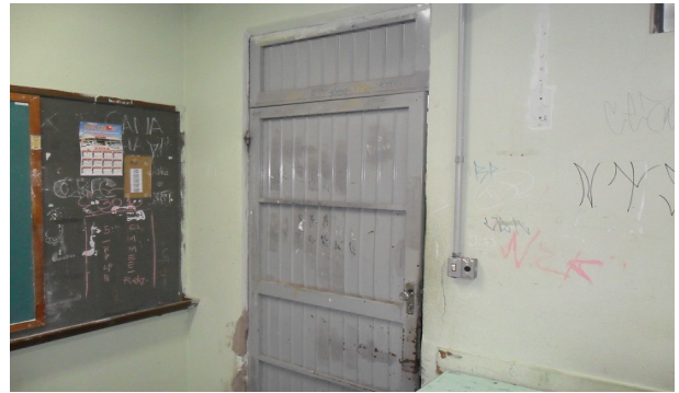
Figura 5: Detalhe de uma sala de aula
