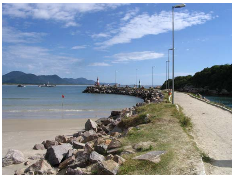
Figura 2.2: Molhe do canal da Barra, onde está localizado o RN da Celesc e de onde partem as amarrações dos RN's dos perfis praias.
